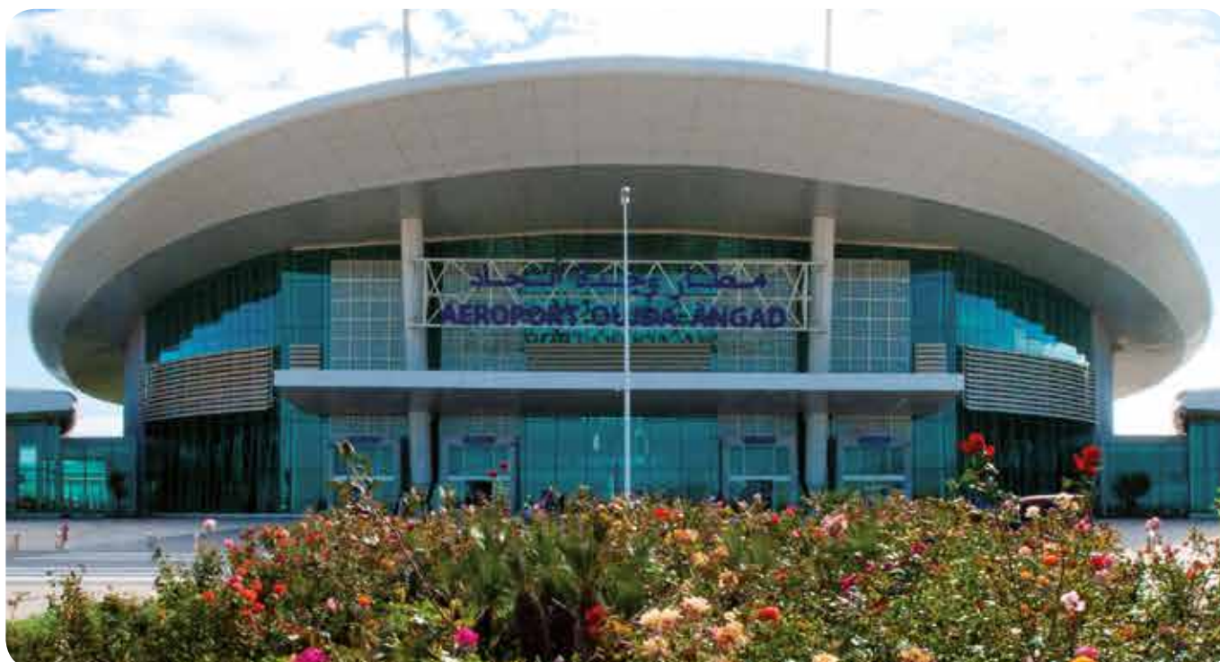
L'aéroport d'Oujda-Angad, inauguré en 2010 : le troisième du Royaume par sa capacité
