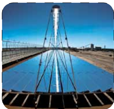
Mise en œuvre de la technologie CLFR développée par AREVA Solar
