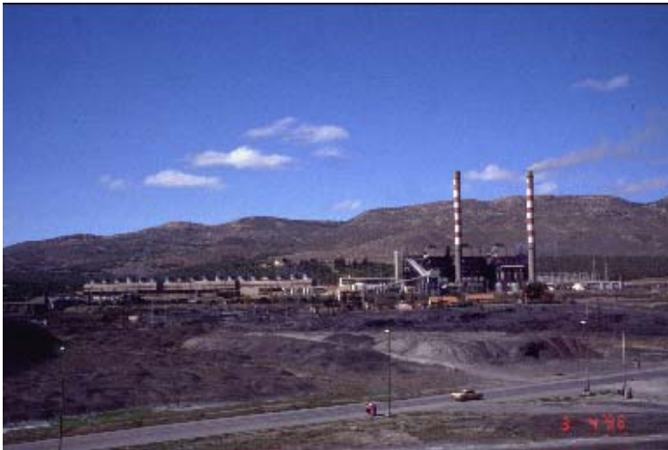
Photo 2.3.3.a : La centrale thermique de Jerada.
